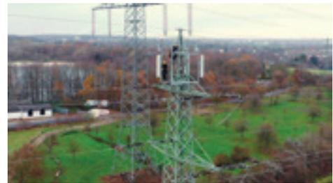
Für die Umrüstung als Antennenstandort eignen sich insbesondere Hochspannungsmasten, die jünger als 60 Jahre sind. Besonders prädestiniert sind sogenannte Winkel- und Abspannmasten, da diese massiver dimensioniert sind als Tragmasten auf gerader Strecke.
