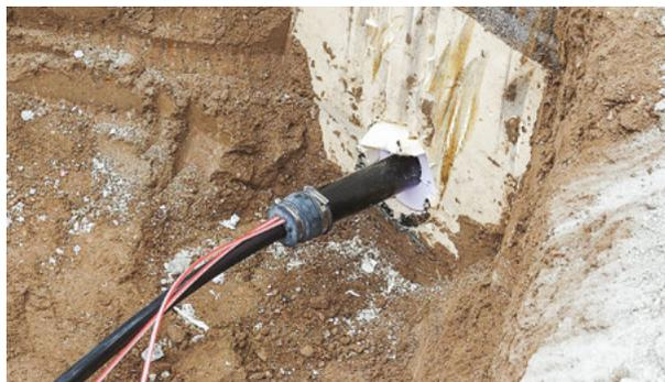
Abbildung 27: Mehrpartenhouseinführung an der Gebäudeaußenwand
