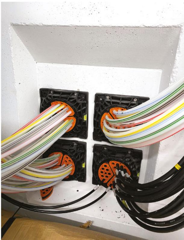
Abbildung 26: Vier separat installierte Einspartenhouseinführungen unterschiedlicher Netzbetreiber
