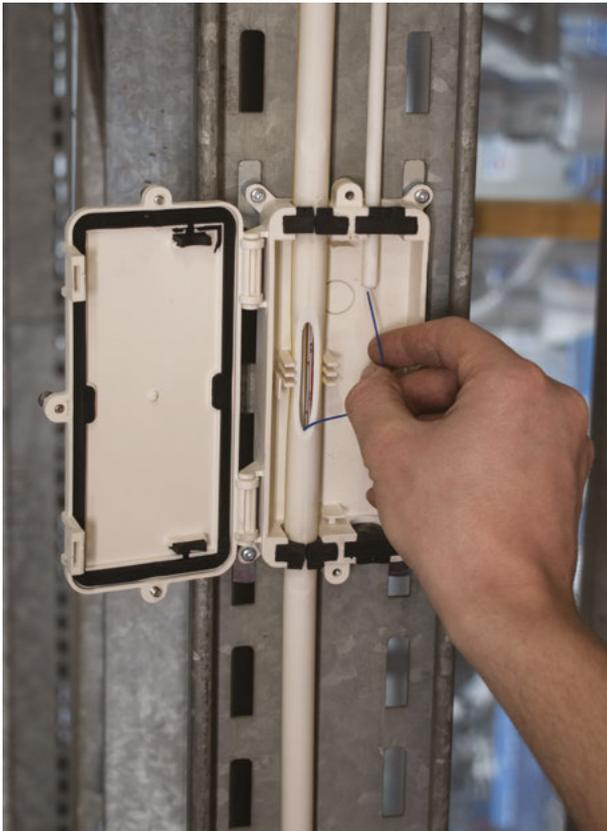
Abbildung 57: Ausleitung von Glasfaserkabeln aus einer Steigleitung heraus
