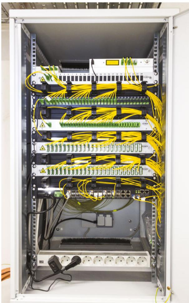
Abbildung 37: GF-AP für eine PtMP-Verbindung mit Gebäudeverteiler für 64 WE
