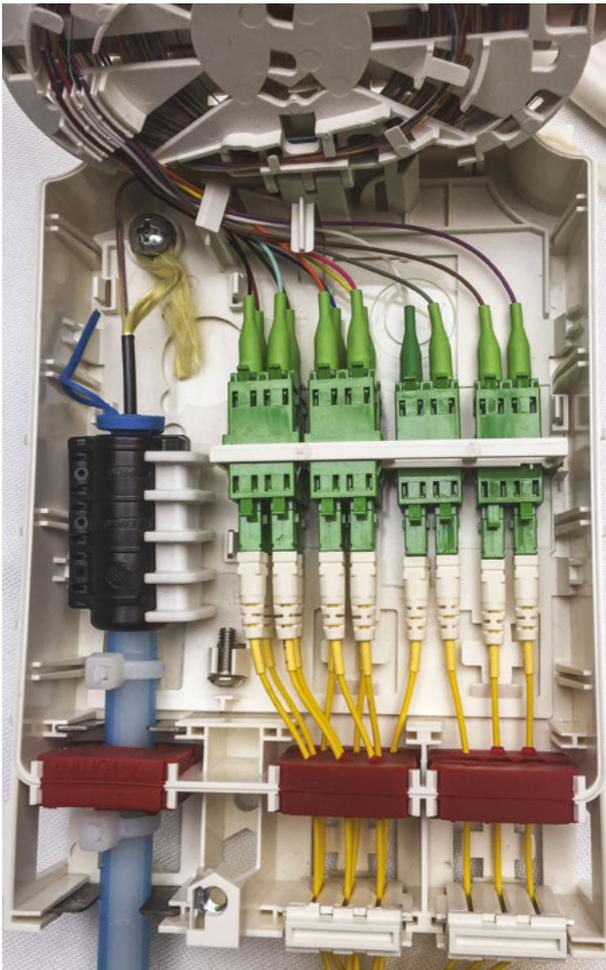
Abbildung 33: GF-AP mit Mikrorohreinführung
