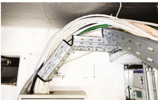
Abbildung 44: Kabelführungssystem für eine Glasfaser-Verteilung über Kabel (oben) und über Mikrorohre (unten)
