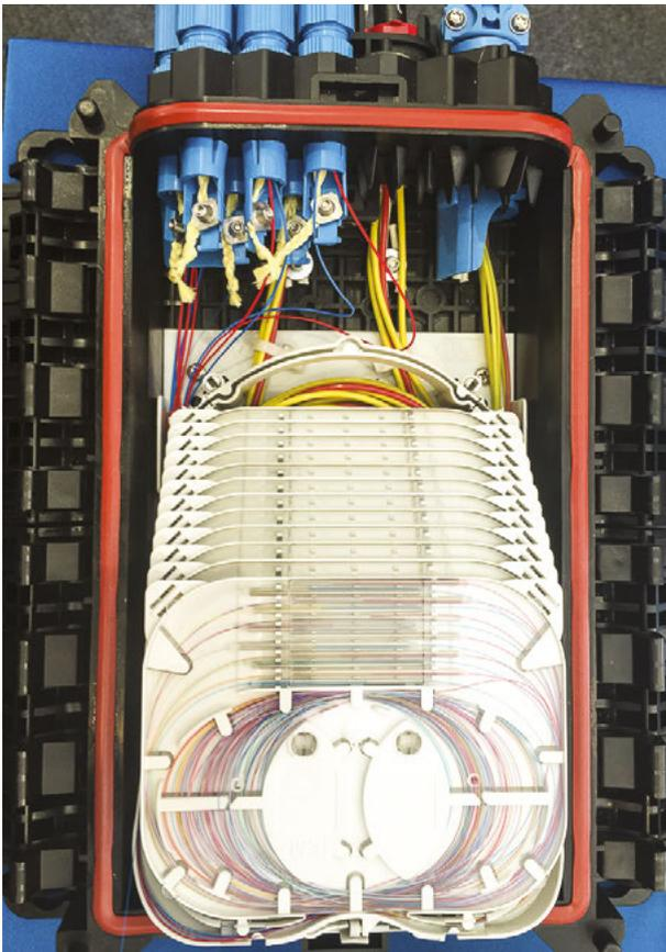
Abbildung 14: Muffe zur Verbindung von Zuleitungsebene und Ableitungsebene
