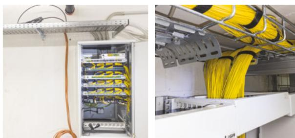
Abbildung 46: Gebäudeverteiler und Einzelfaser-Verteilung über Kabelführungssystem
