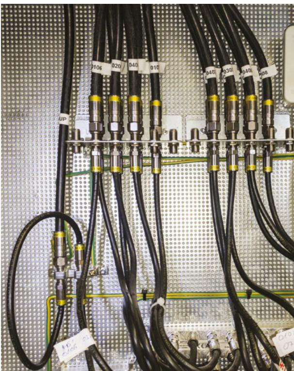
Abbildung 42: HFC-Verteilung mit Multitaps zur Versorgung der WE in Sternverkabelung
