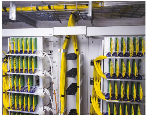
Abbildung 48: Einzelfaser-Management zur Anbindung der WE (FTTH)
