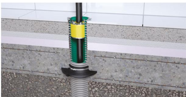
Abbildung 21: Einspartenhouseinführung mit erdverlegtem Elektroinstallationsrohr und variablem Dichteinsatz (bis zu vier Kabel oder Rohre von 7 bis 18 mm) durch Kernlochbohrung (oben) bzw. durch eine Bodenplatte (unten)
