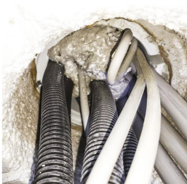
Abbildung 60: Brandschottung von Elektroinstallationsrohren und Kabeln in einem Steigschacht
