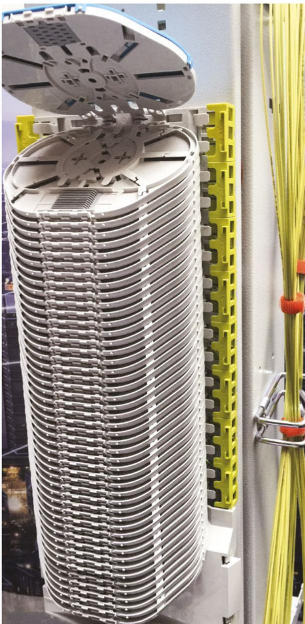
Abbildung 35: Einzelfaser-Management am GF-AP für eine PtP-Verbindung
