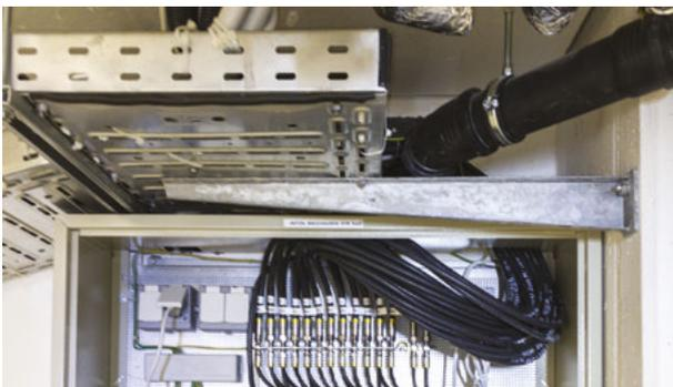
Abbildung 41: HFC-Gebäudeverteiler mit darüberliegendem Kabelführungssystem/Kabelwanne
