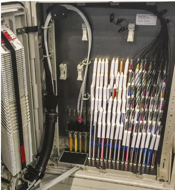
Abbildung 12: Aufbau eines KVz (in diesem Beispiel genutzt als Netzverteiler) mit Verbindungen zur Zuleitungs- und Ableitungsebene
