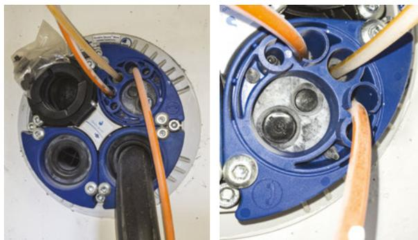
Abbildung 28: Mehrparteneinführung mit Zugang für Strom- und drei Telekommunikations-Netzbetreibern
