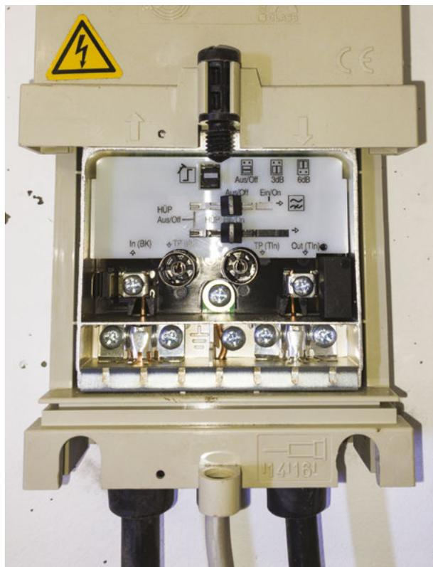
Abbildung 32: HFC-ÜP im geschlossenen und geöffneten Zustand (koaxiale Verkabelung)
