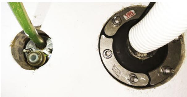
Abbildung 22: Einspartenhouseinführung für einen bzw. zwei Netzbetreiber
