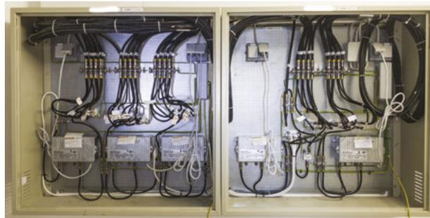
Abbildung 40: Koaxial-Gebäudeverteiler für 24 WE (oben) bzw. 36 WE (unten)
