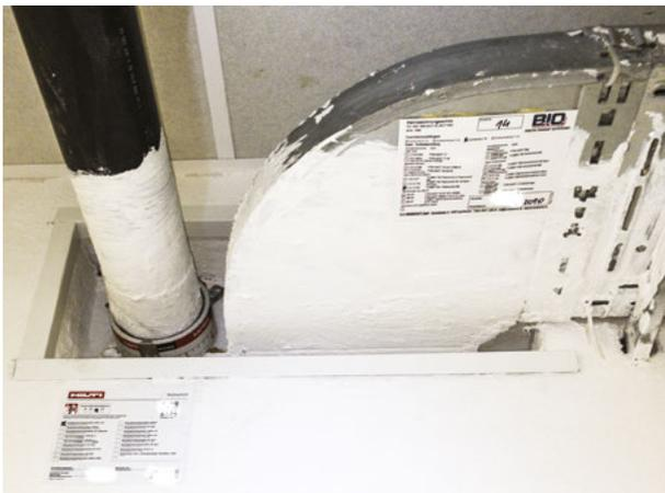
Abbildung 59: Brandschottung für eine Kabelwanne und ein Abflussrohr
