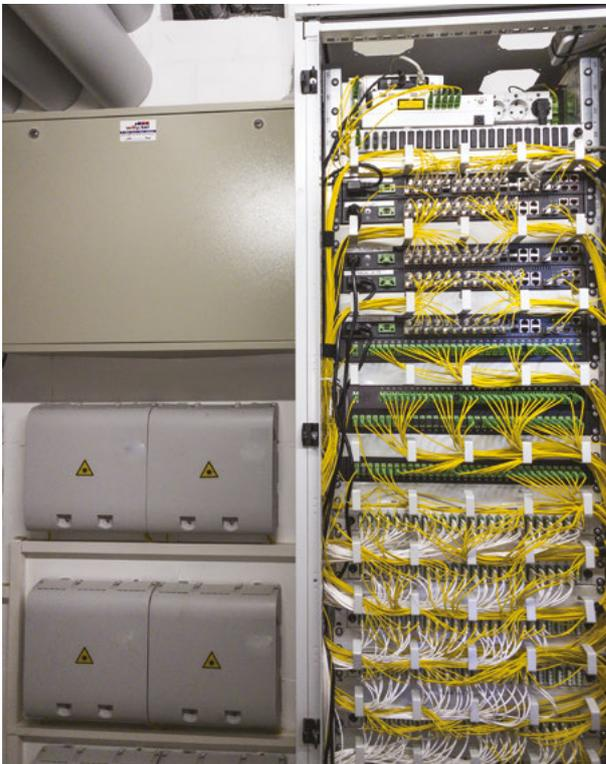
Abbildung 47: FTTH-Wohnanlage mit 100 (oben) bzw. 60 (unten) WE, Nutzung von Glasfaser-Netzinfrastrukturen unterschiedlicher Anbieter; Netzkomponenten für PON (links) und PtMP mit aktiver Technik für IP und DVB-C/CATV (rechts)
