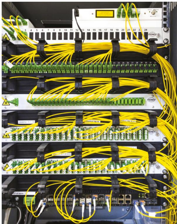
Abbildung 45: Aktiver PtMP-Gebäudeverteiler mit Patchfeldern
